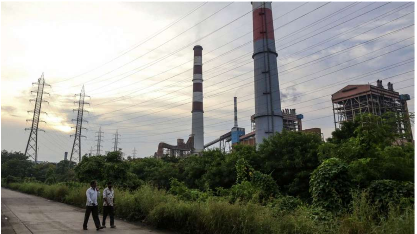
Fig. 29 - Centrale à charbon en Inde (source d'énergie représentant encore plus de 70% de la production d'électricité du pays en 2021).
